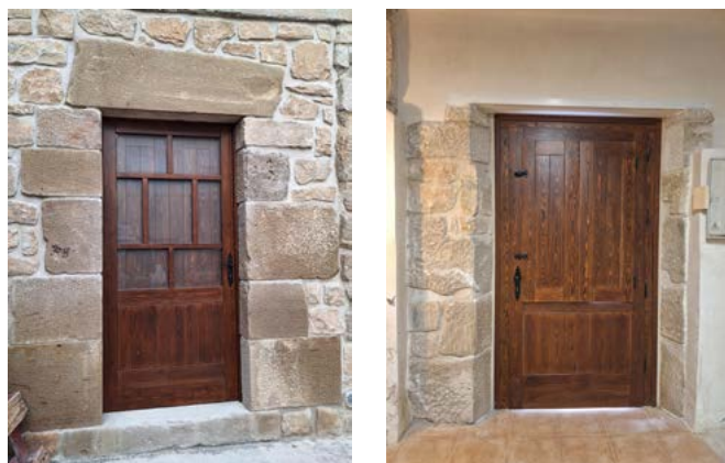
Vista exterior i interior de la porta després de les obres
