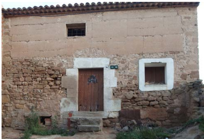
Cal Vilanova (antigament cal Casaca) amb el portal.
