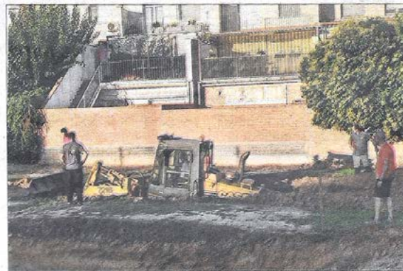
Imatge dels treballs d'adaptació del terreny.
