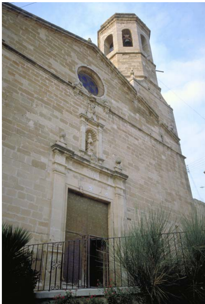
Vista de la façana de l'església. Codi Ref. ANC1-428-N-17147
