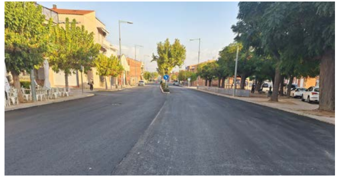
Obres a la carretera de Lleida
