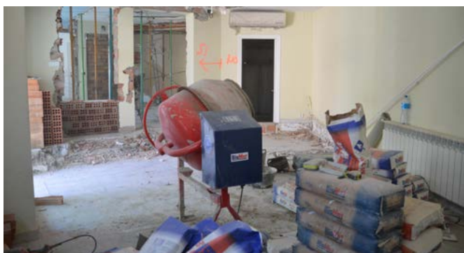
Obres al consultori mèdic
