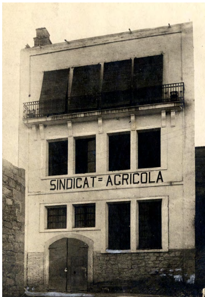
Façana posterior del Sindicat de Sant Isidre
